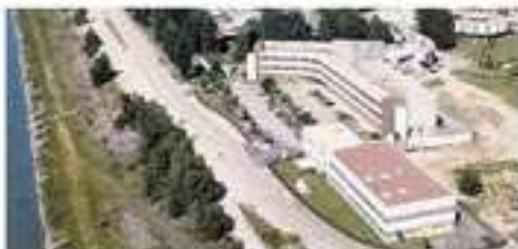
Vue aérienne SCA Solaize
